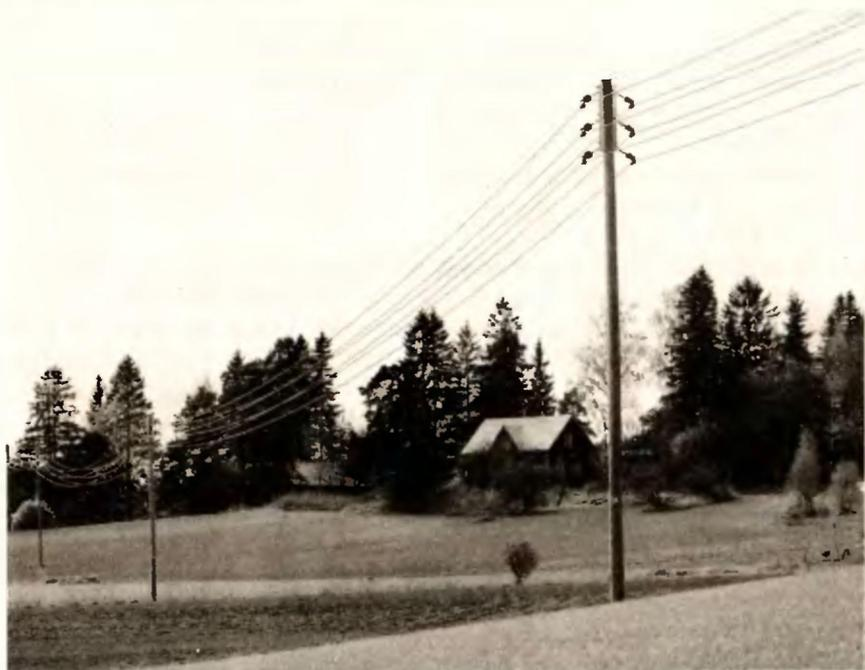
Рис. 13.39. Двухцепная линия напряжением 6...10 кВ (промежуточные опоры)
