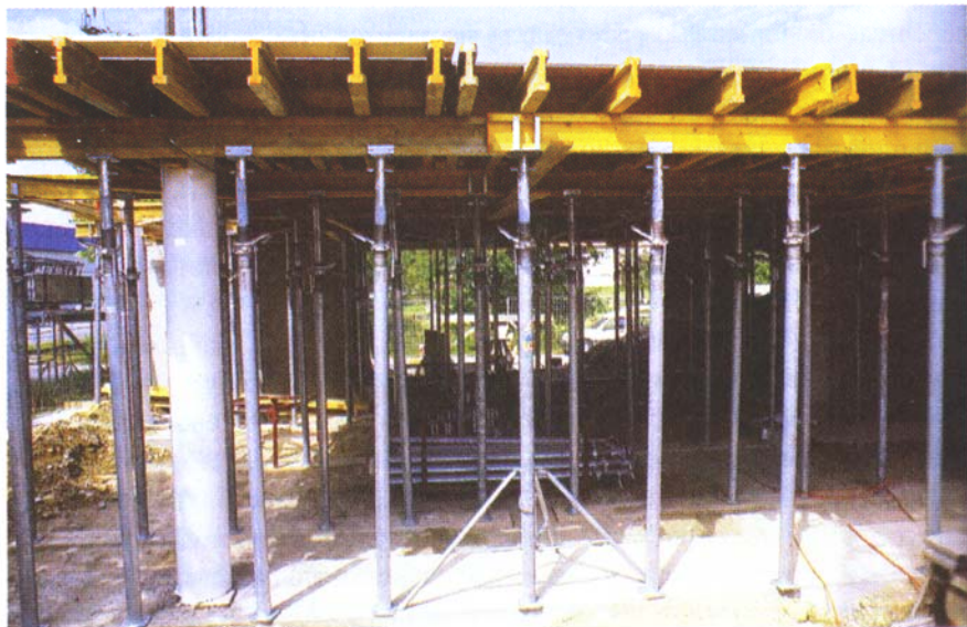
Рис. 2.11. Общий вид опалубки «PASCHAL Дек»
