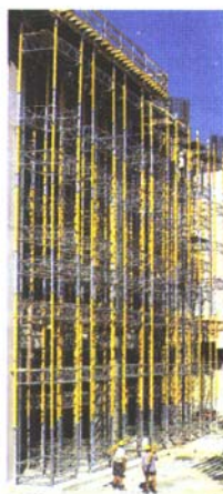
Рис. 3.40. Опорные башни: а - ST 100; б - PD 8; в - MULTIPROP с рамами MRK
