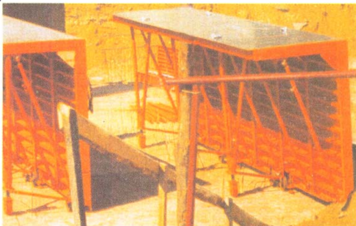
Рис. 2.23. Тоннельная опалубка фирмы «НОЕ»: а - общий вид; б - Г-образный элемент тоннеля
