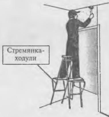
Рис. 84. Облицовка стены над дверным проемом
