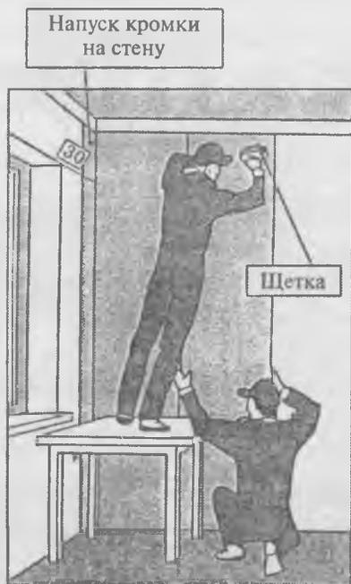
Рис. 54. Наклейка второго полотнища
