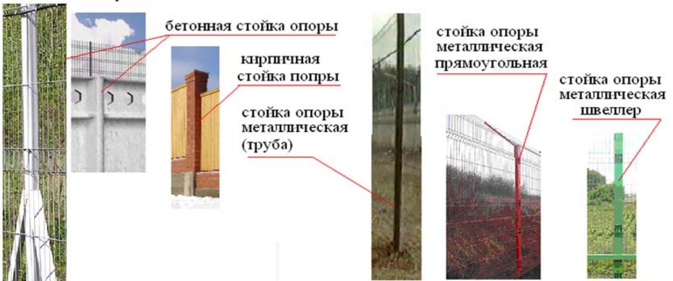
Рис. 13. Наиболее часто применяемые стойки опор инженерного ограждения.
