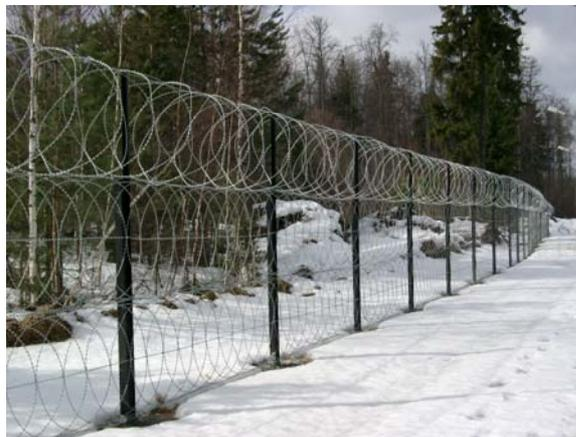
Рис. 6 б). Основное ограждение: среднее, просматриваемое, гибкое (АКЛ), опоры ограждения – металл, постоянное, строительное (инженерное)
