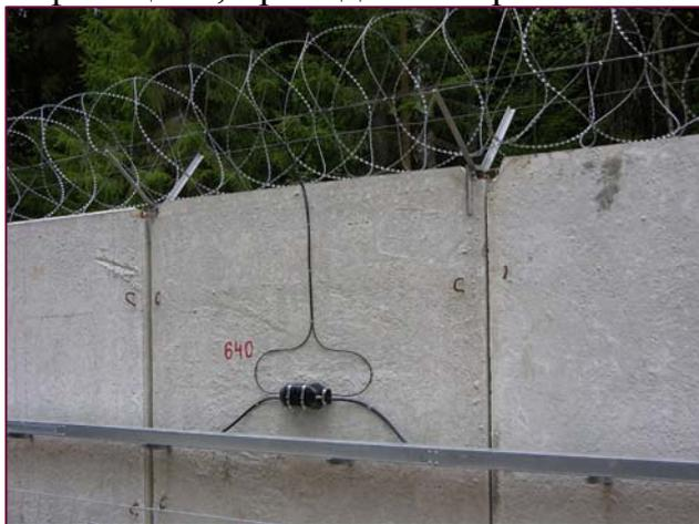
Рис. 6 а). Основное заграждение: высокое, сплошное (не просматриваемое), жесткое, глухое (бетон), постоянное строительное (инженерное).
