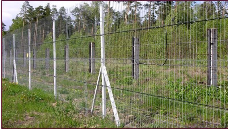
Рис. 6 б). Основное ограждение: высокое, просматриваемое, гибкое, прозрачное (сетка), опоры ограждения – бетон, постоянное, строительное (инженерное).
