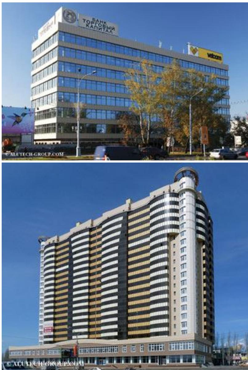
**Рис. 32.** Стоечно–ригельный фасад рамного остекления.
