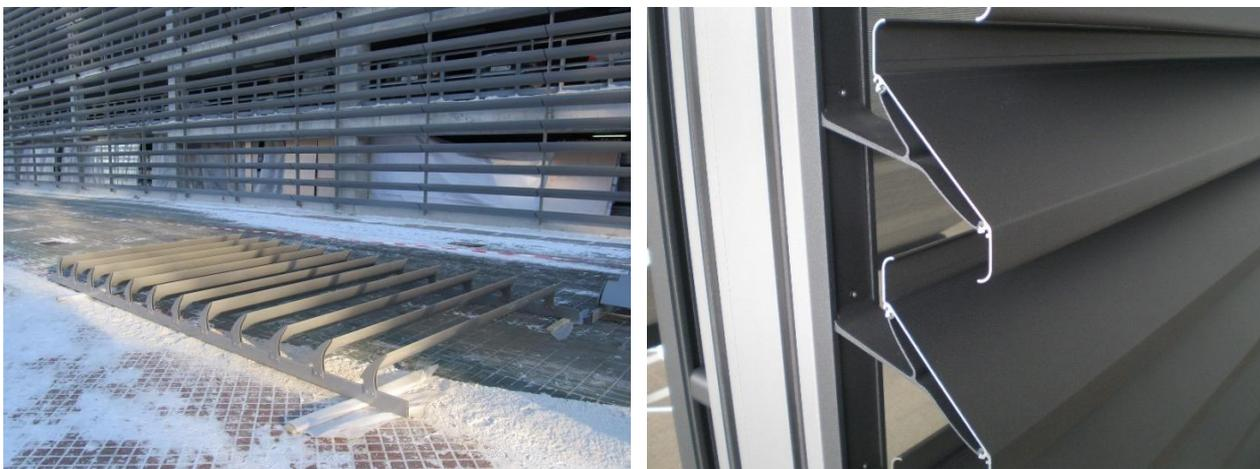
**Рис. 21.** Фасад жалюзи с горизонтальным расположением ламелей. Деталь.
