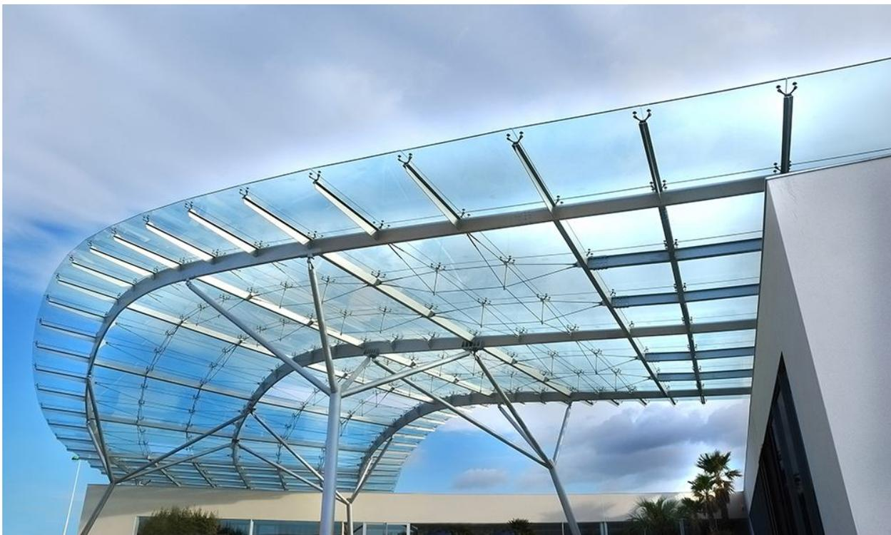
**Рис. 47.** Спайдерное остекление козырька входа.
