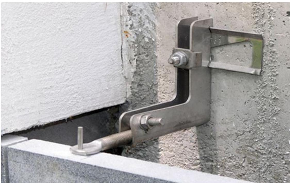
**Рис 19.** Система крепления HALFEN для натурального камня.
