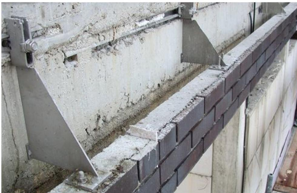
**Рис 15.** Фасадная система HALFEN НК4.
