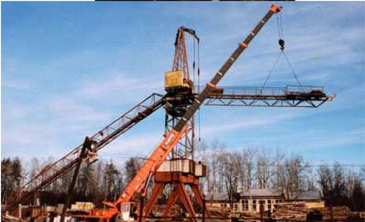
Рисунок 39 – Монтаж противовесной консоли башенного крана КБ-572
