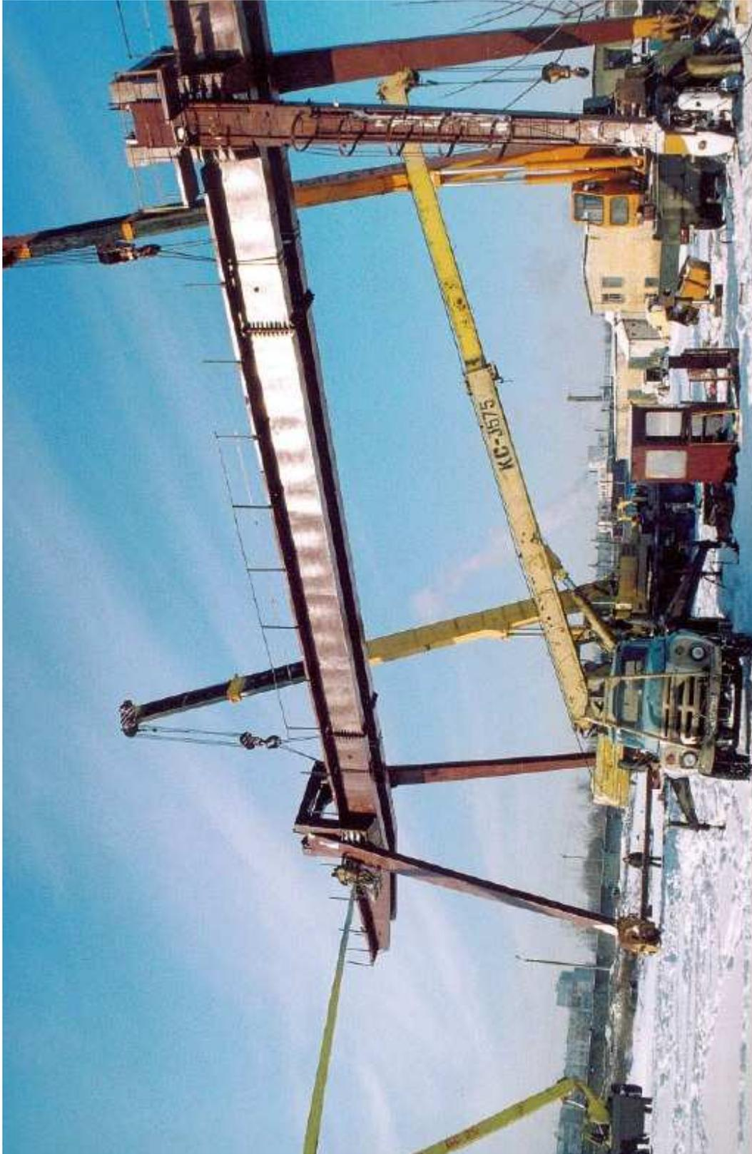
Рисунок 18 – Монтаж крана ККЛ-32 автомобильными кранами
