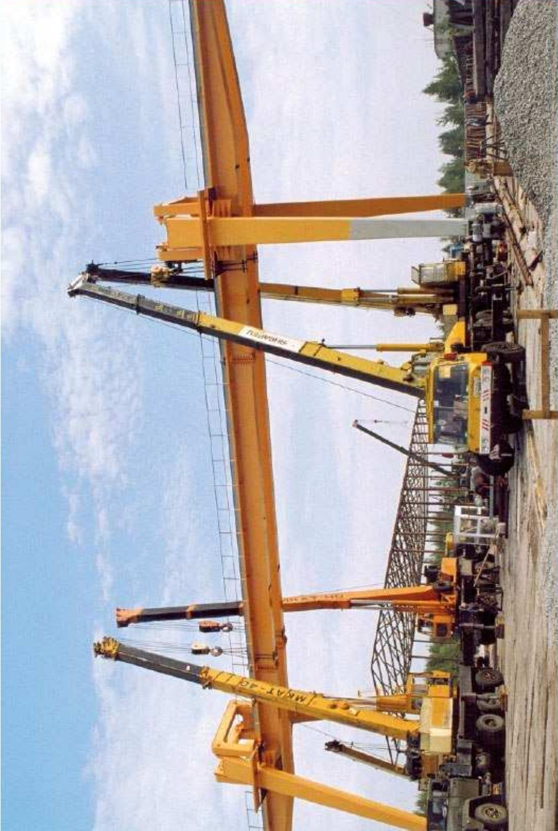
Рисунок 17 – Монтаж крана ККЛ-32 автомобильными кранами
