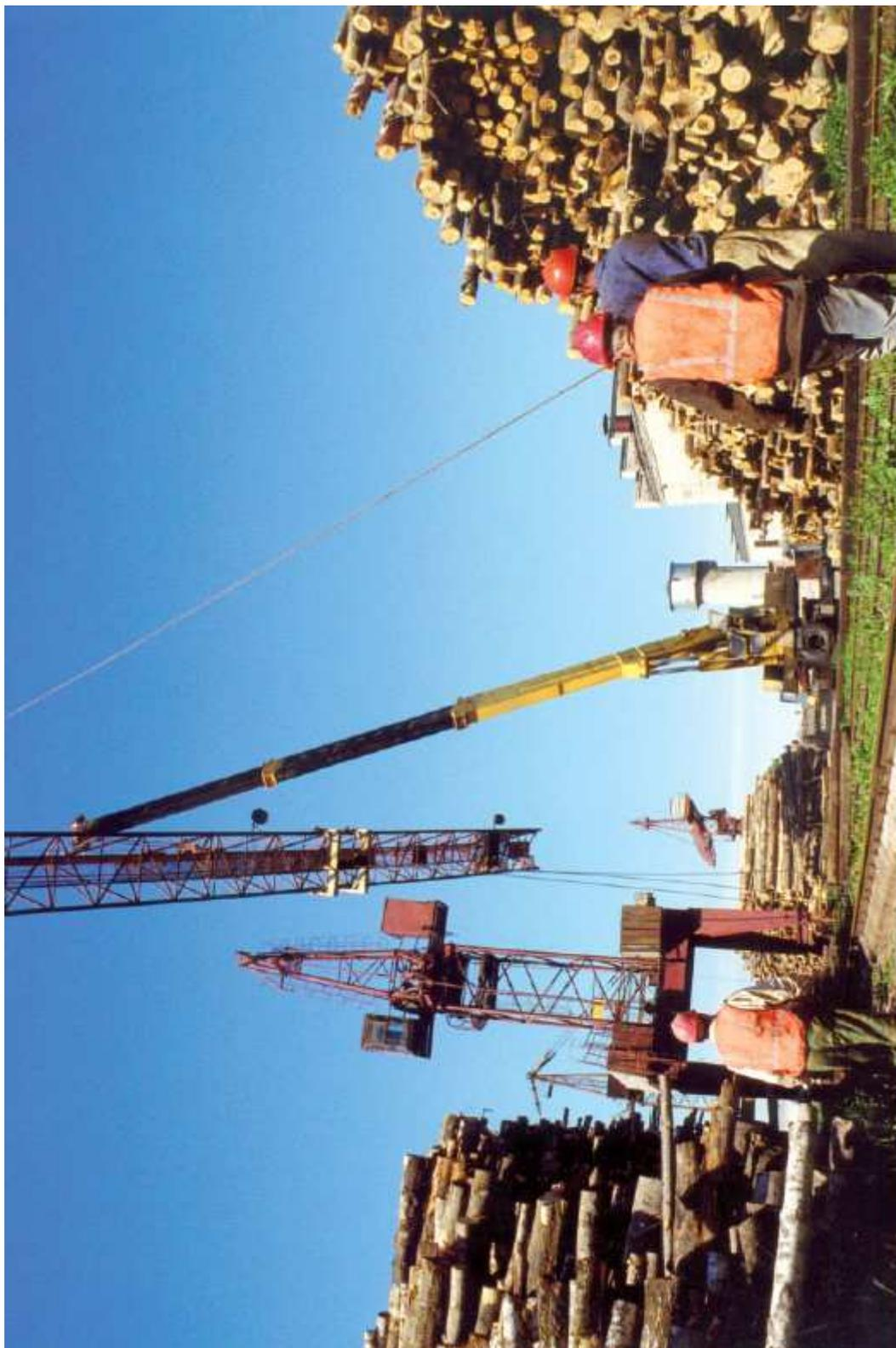
Рисунок 38 – Монтаж стрелы башенного крана КБ-572
