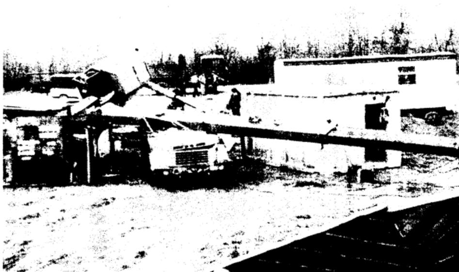
Рис. 1. Авария автомобильного крана КС-4579
