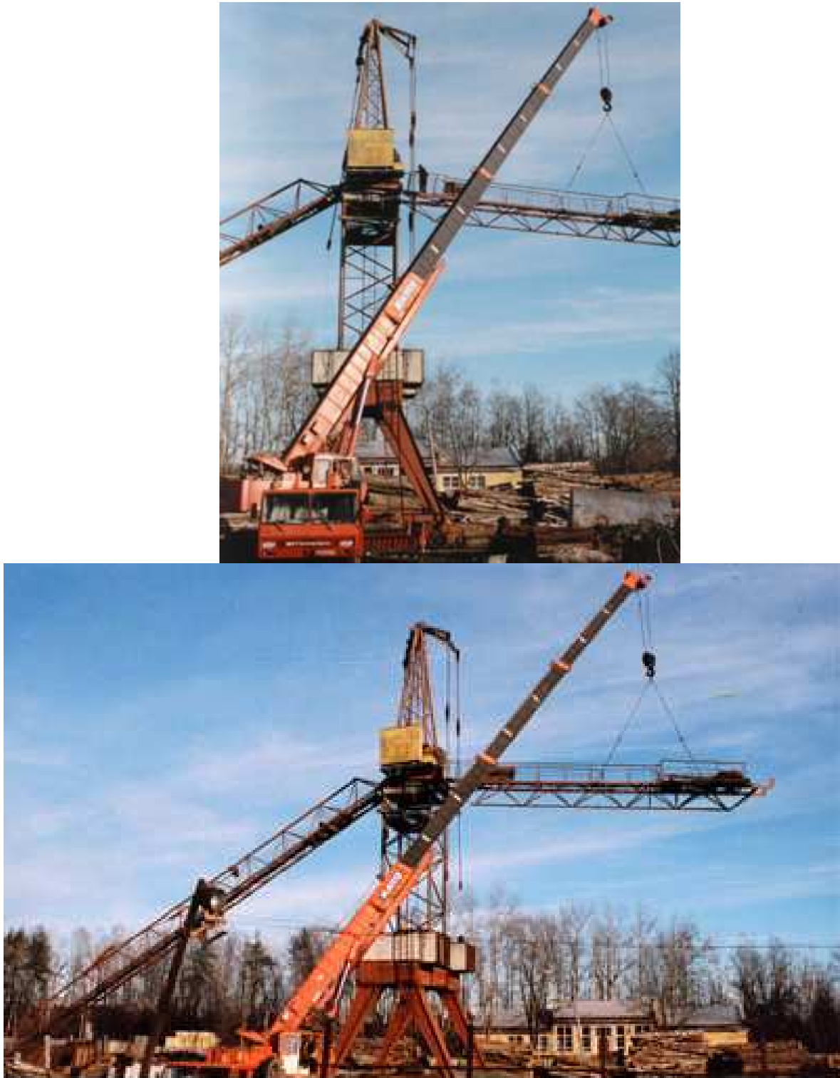
Рисунок 39 – Монтаж противовесной консоли башенного крана КБ-572
